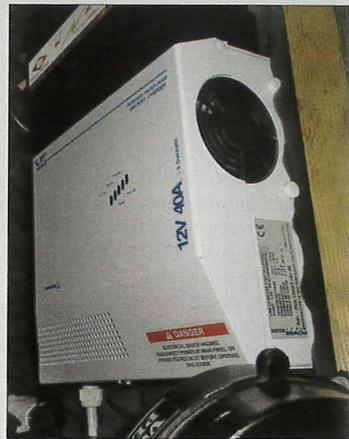
*Que le chargeur soit pourvu ou non d'un ventilateur, on veillera à l'installer dans un endroit suffisamment aéré pour éviter tout risque de surchauffe.*
