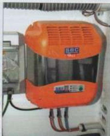
Que le chargeur soit pourvu ou non d'un ventilateur, on veillera à l'installer dans un endroit suffisamment aéré pour éviter tout risque de surchauffe.
